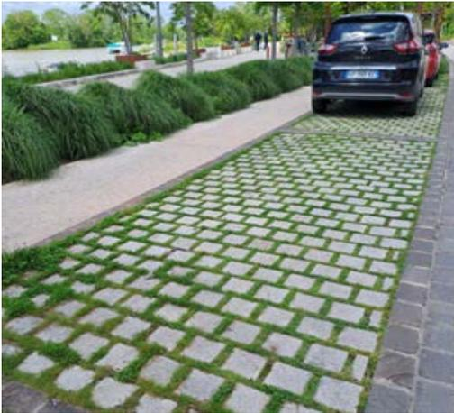
Revêtements perméables pour le stationnement (pavés à joints enherbés, dalle béton engazonnée...).
