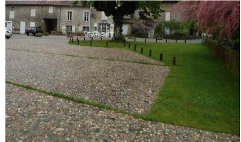
Place de stationnement matérialisée par joint de dilatation enherbé.
